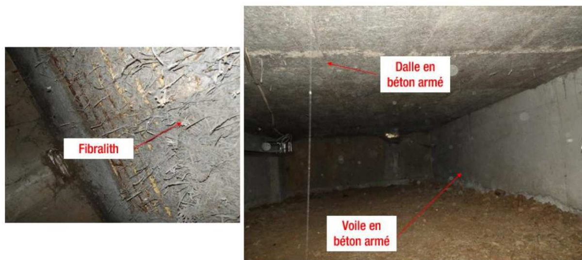
Figure 11: Photographies du système constructif du vide sanitaire
